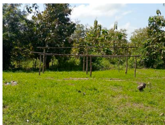
新クラスルームの建築予定地
