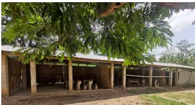
工事以前からあるクラスルーム
